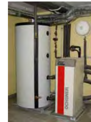
Wärmepumpe
