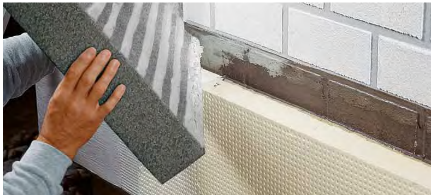
Außenwanddämmung
