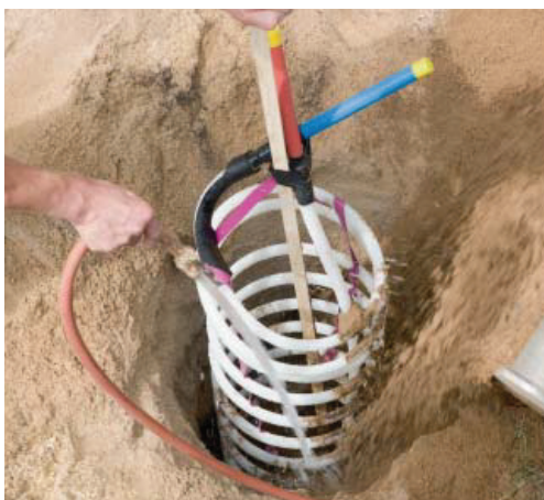
Einbau einer RAUGEO Helix PE-Xa
